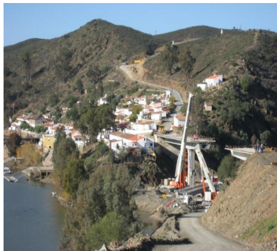
El puente de Pomarao en construcción
