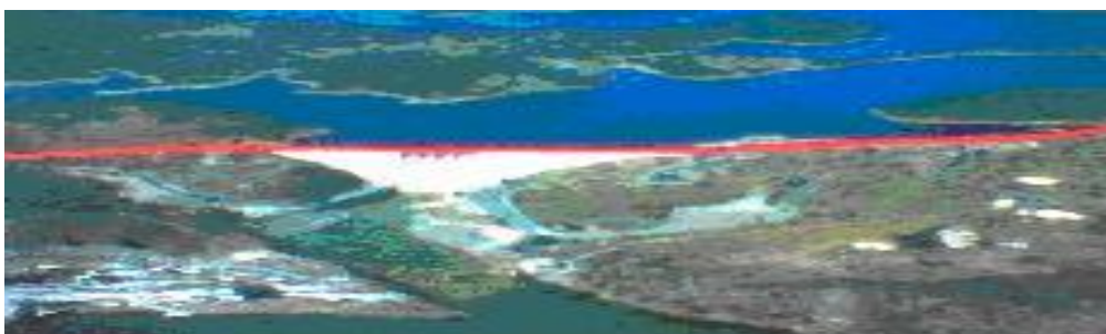
Muro de contención de la Presa del Chanza. El trazo rojo marca la opción de aprovechar el paso existente. Delante, a la izquierda, la población lusa de Pomarao
