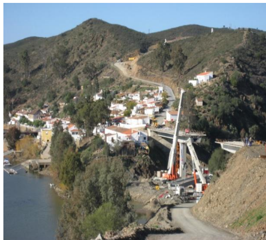
El puente de Pomarao en construcción
