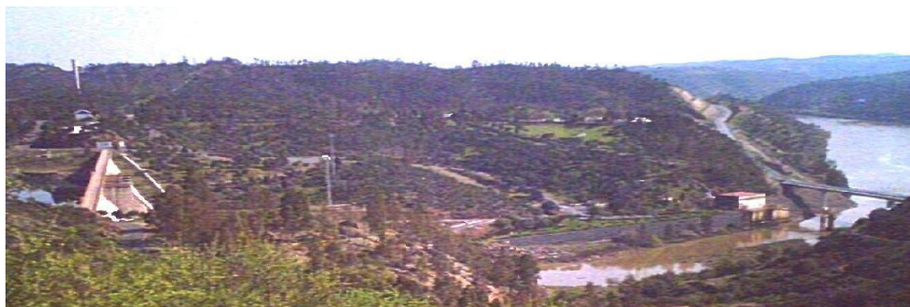
A la derecha el Puente de Pomarao, inaugurado el 26.02.09. A la izquierda el paso existente, desechado por la Administración española sin fundamento técnico alguno
